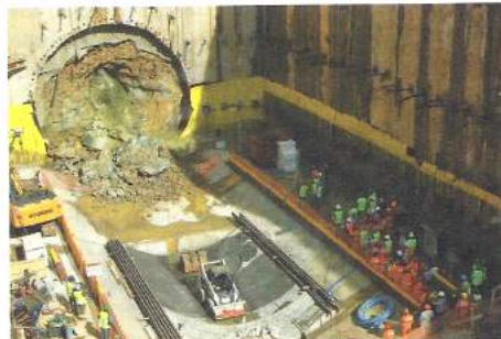
Construção da nova linha do metrô, em São Paulo. Foto de 2014.
